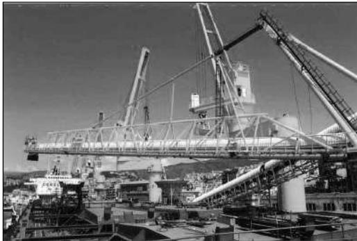
Per conto di Techint Italmimpianti abbiamo sviluppato la progettazione strutturale dell'impianto di transhipment di minerali ferrosi da bordo nave alla banchina.
