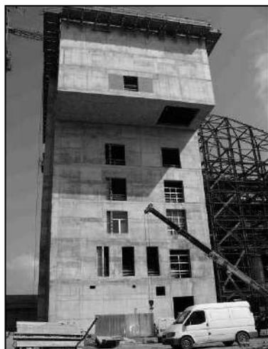
Nell'ambito della progettazione opere civili dell'impianto di termovalorizzazione rifiuti di Gioia Tauro, abbiamo sviluppato la progettazione esecutiva e di dettaglio della struttura dell'edificio Fossa CDR.
