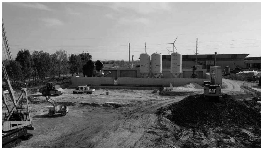
Attualmente sono state terminate le opere in c.a. del capannone Eiezione e Trattamento e stanno per iniziare i montaggi della struttura metallica.
