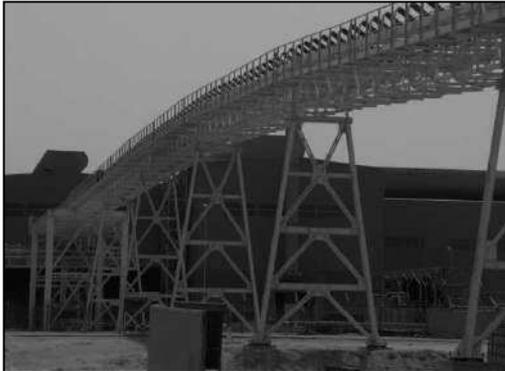
Nell'ambito della realizzazione del nuovo impianto denominato “Rebar and wire mill project” presso lo stabilimento GHC – Emirates Iron Steel Factory - D.R.I. di Abu Dhabi (U.A.E.) abbiamo sviluppato, per conto di Techint Technologies, la progettazione strutturale esecutiva delle strutture metalliche dell'impianto, per un totale di circa 2.700 t di carpenteria metallica.
